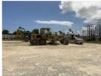
Maquinarias utilizadas para hacer Nivelación de Terreno
