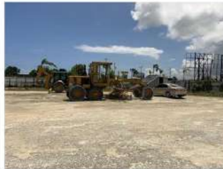
Maquinarias utilizadas para hacer Nivelación de Terreno
